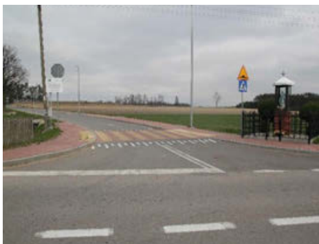
Droga w miejscowości Hodyszewo. Wartość inwestycji 1 208 900 zł
