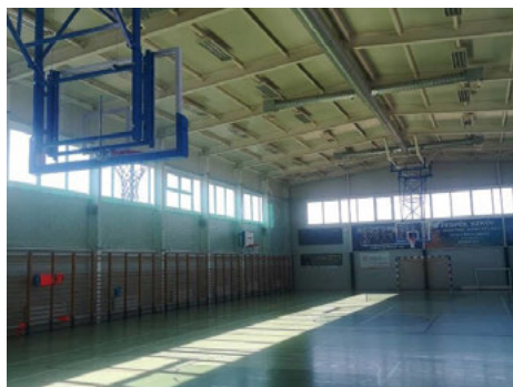
Wymiana pokrycia dachowego i okien w sali gimnastycznej w Szkole Podstawowej w Jabłoni Kościelnej
