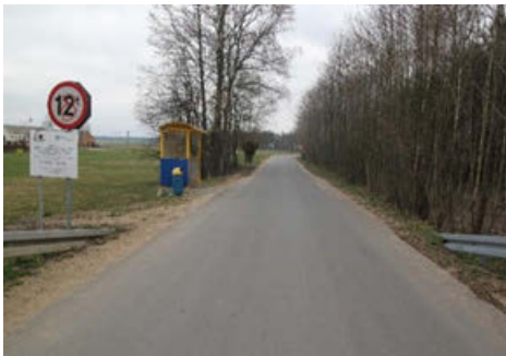
Droga w miejscowości Koboski. Wartość Inwestycji 503 584 zł
