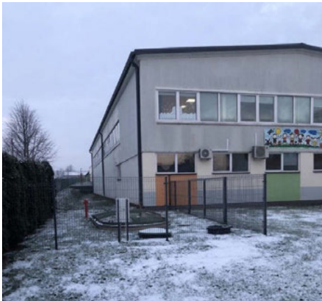
Oczyszczalnia ścieków przy Zespole Szkolno-Przedszkolnym w Jabłoni Kościelnej
